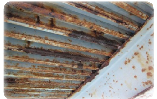
▲写真 3 腐食によって生じた腐食の事例（鋼橋：主桁、床版）
