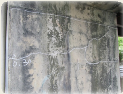
▲橋柱部のひびわれの事例 (コンクリート橋)
