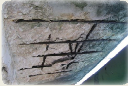
▲鉄筋露出・剥離の事例 (コンクリート橋：床版)
