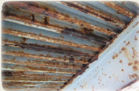
▲腐食によって生じた錆の事例 (鋼橋：主桁)
