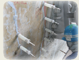
▲ひびわれ注入施工の様子
