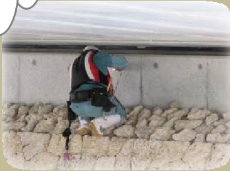
①橋の点検調査の実施
