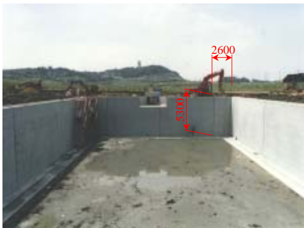
写真 - 1 掘込式貯水池施工状況
