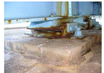
写-1 既設鋼製支承
