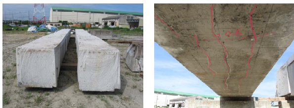
写真-2 劣化試験PC桁の状況写真
