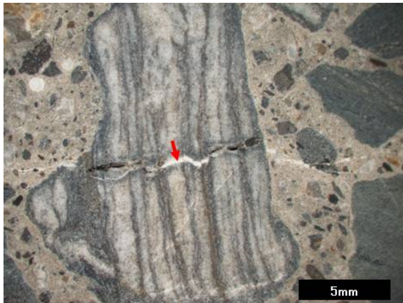
写真-9 泥質片岩(粗骨材)に生じたASRゲル(矢印)
