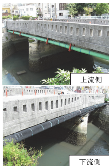
写真-1 研究対象橋梁撤去前の外観状況
