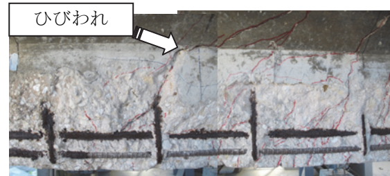
a) 桁 WEB のひび割れと破壊
