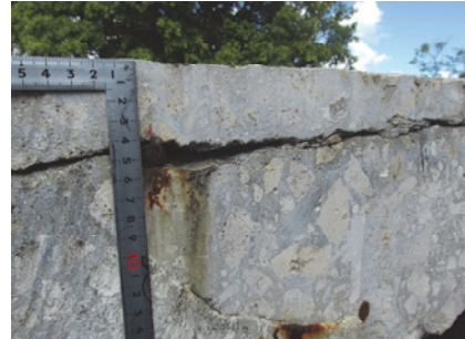
写真-8 W-3 RCT 桁床版のスペン中央付近の水平ひびわれ
