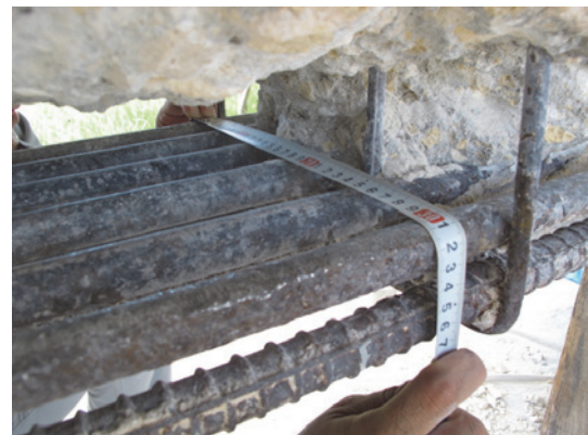
写真-10 引張試験に用いた鉄筋(解体状況)
