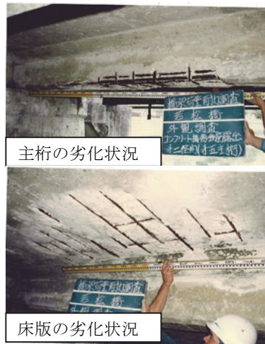
写真-2 平成6年度(竣工後38年)の損傷状況
