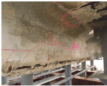
写真-6 W-1 RCT 桁の劣化状況
