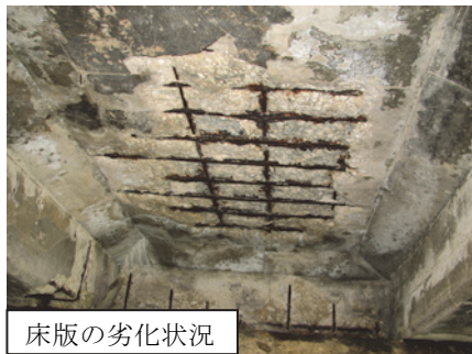
写真-3 平成 17 年度(竣工後 49 年)の損傷状況
