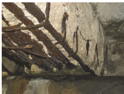
写真-4 平成 17 年度(竣工後 49 年)の鉄筋断面欠損・破断状況
