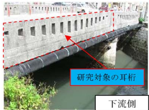
写真-1 研究対象橋梁撤去前の外観状況
