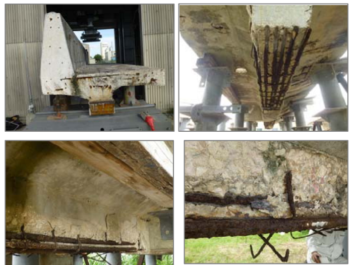
写真-2 試験体W-3 の劣化状況
