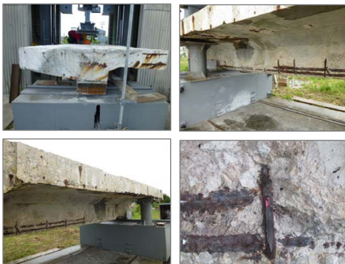
写真-3 試験体W-7の劣化状況
