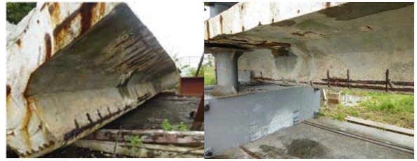
写真-4 試験体 W-7 の劣化状況
