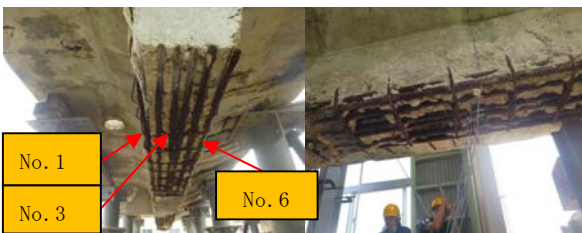
写真-3 試験体 W-3 の劣化状況
