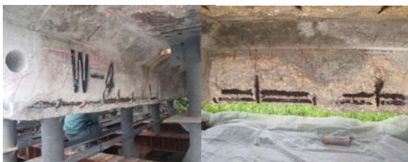
写真-2 試験体 W-4 の劣化状況
