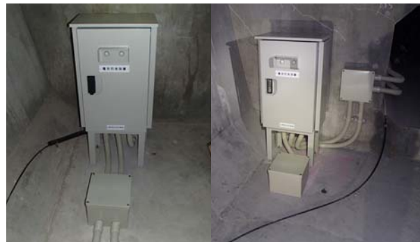
図-11 親機（左）、子機（右）設置状況
