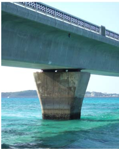
写真-1 橋脚の供用環境
